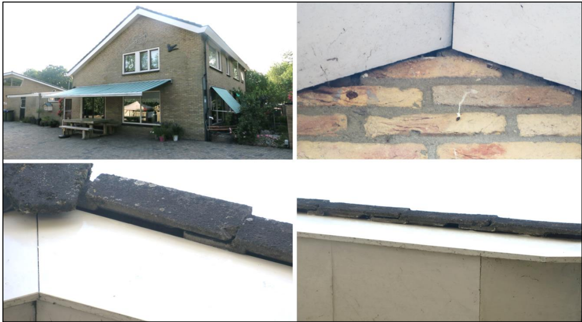
Figuur 3.1 De woning bevat diverse openingen welke voor vleermuizen gebruikt kunnen worden als invliegopening.
