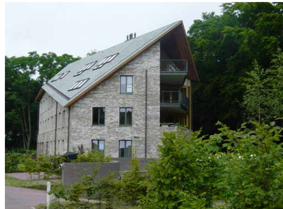
Het dak loopt door over de gevels
