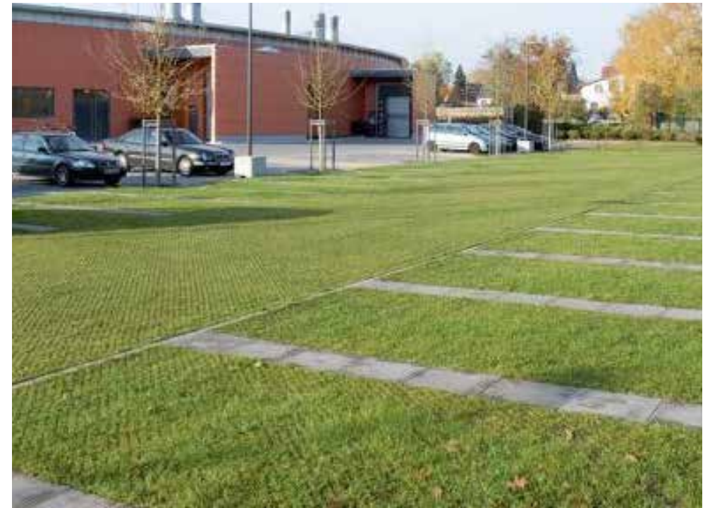
Langsparkeren: grasbetontegels, of zoals hier verhard gras
