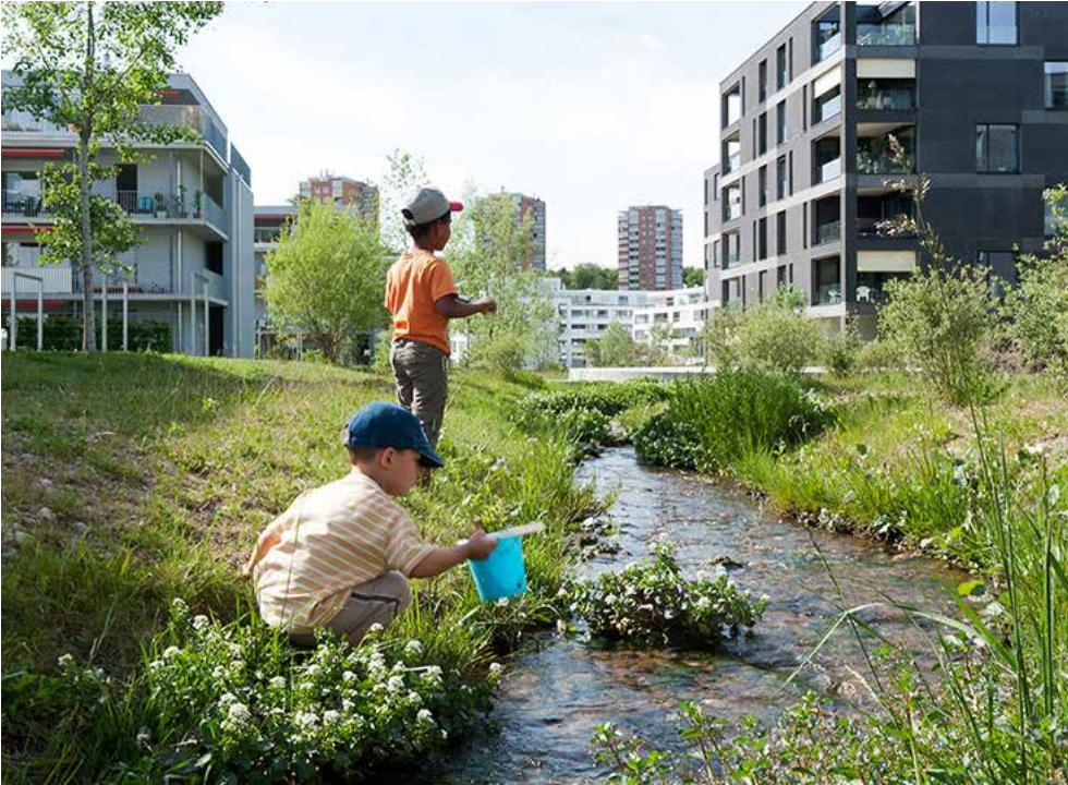
Ruimte voor wateromvang/-infiltratie in de wadi's
