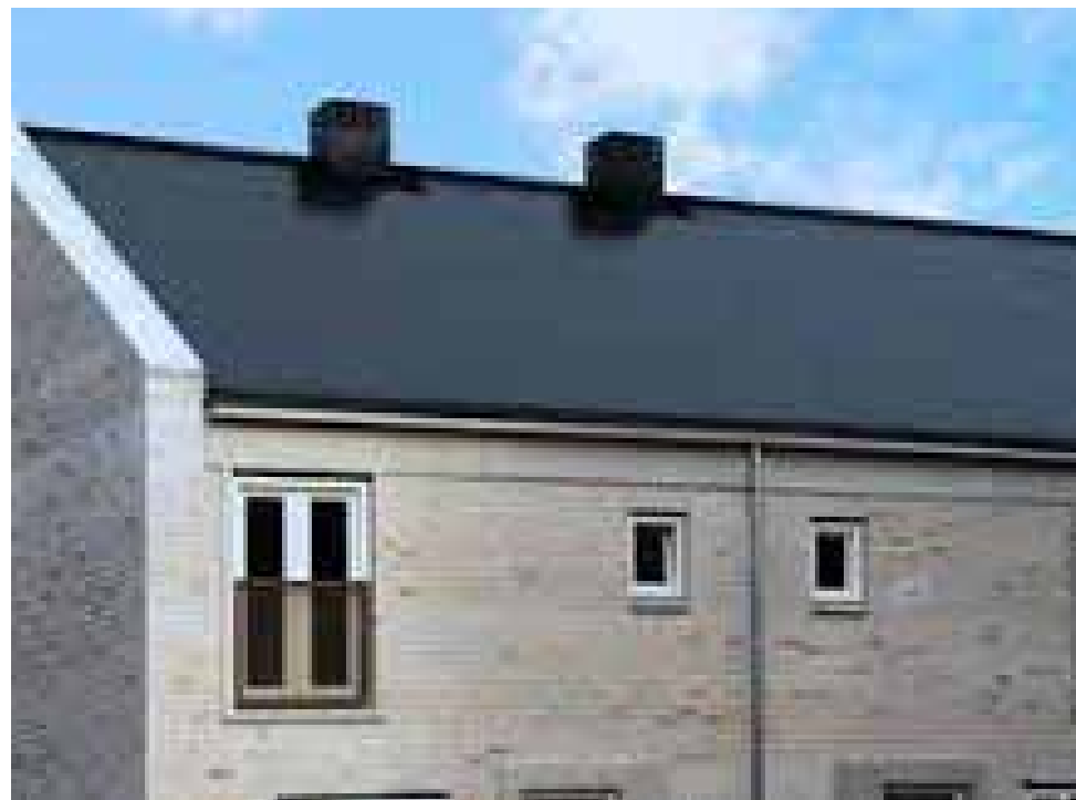
Buitenunits van warmtepompen geïntegreerd als schoorsteen
