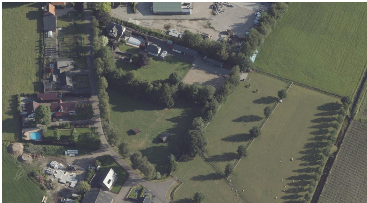
Afb 4: luchtfoto van locatie Parallelweg 1 (bron: StreetSmart)
