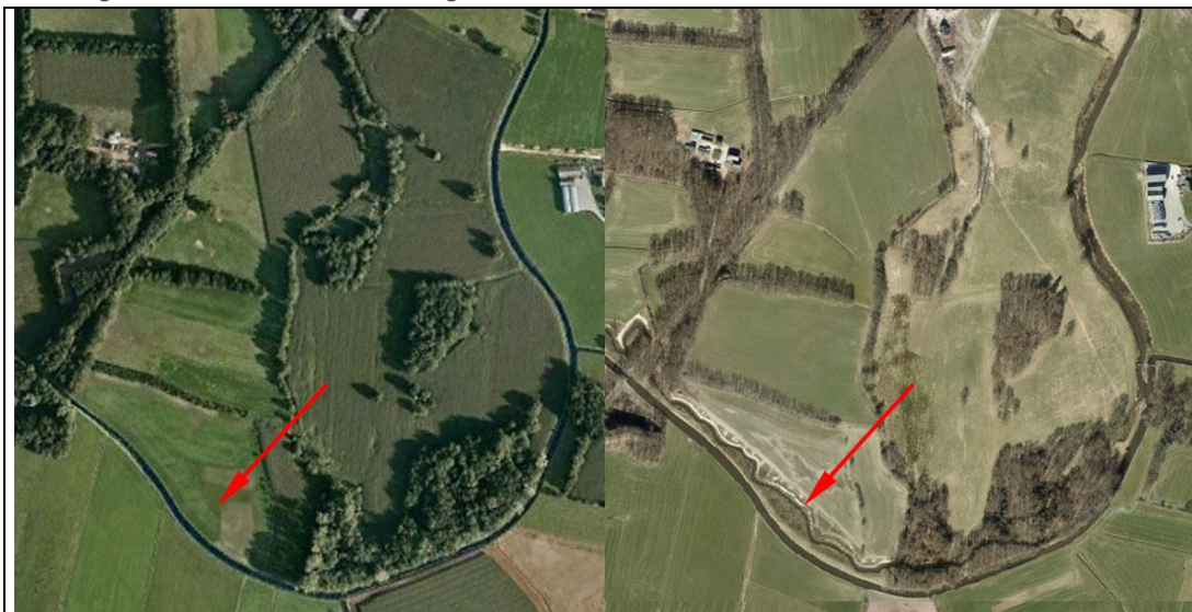
Afbeelding 8: Luchtfoto voor en na aanleg meander.
