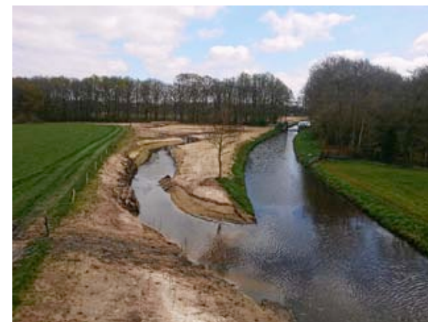
Aanleg van de nevengeul van de Lunterse Beek (foto uit: De Veluenaar van 9 juni 2015)
