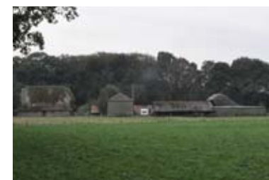
Aanbouwen en bemost dak
