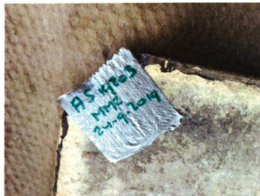
Vlakke plaat (onder de golfplaten)
