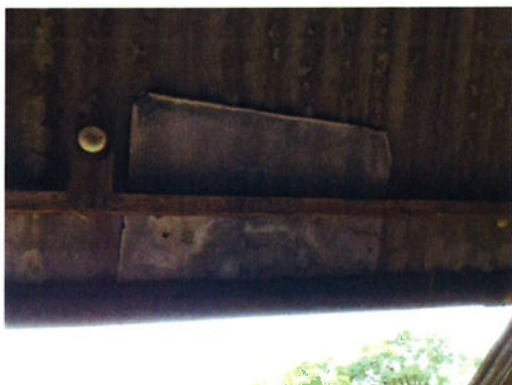
Vlakke plaat (onder de golfplaten)
