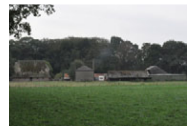
Aanbouwen en bemost dak
