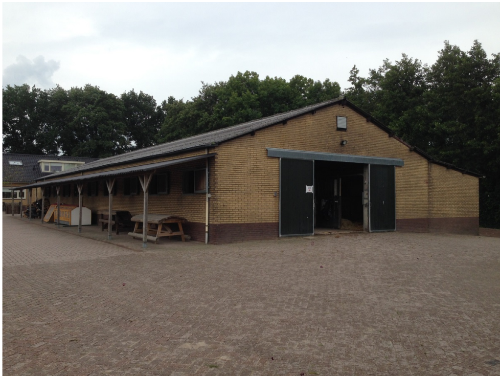
Figuur 3 De te slopen paardenstal, aan de rechterzijde staan alle stalramen open met geschikte vliegroutes naar de bomenlaan.
