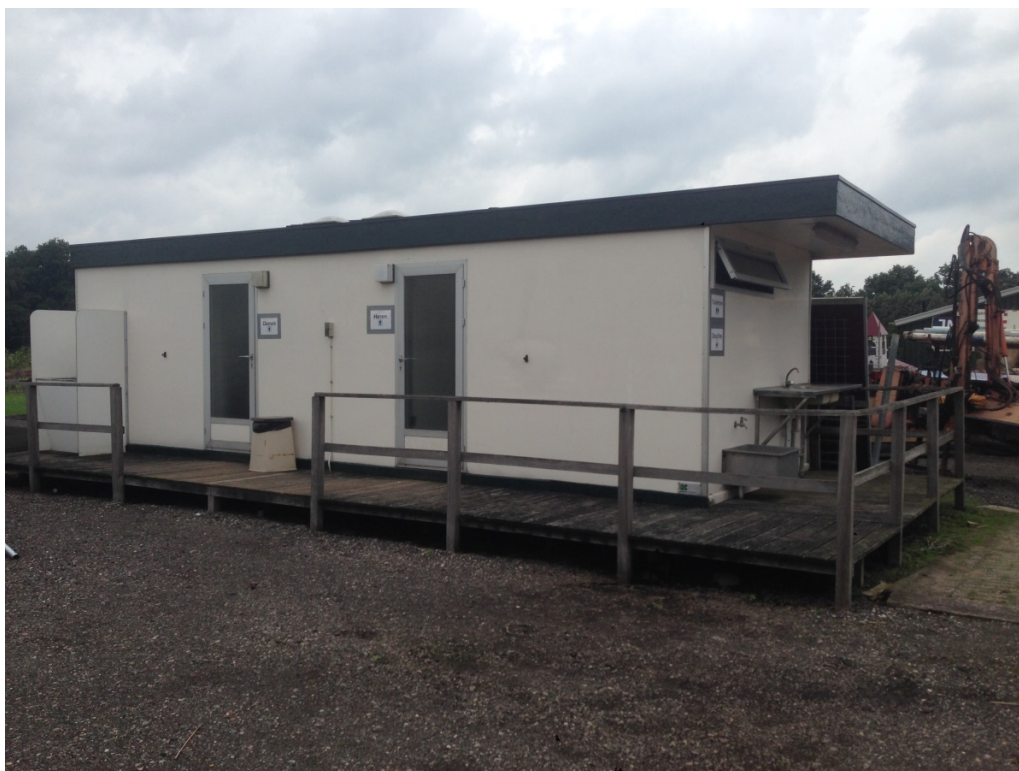
Figuur 2 Het toiletgebouw dat gesloopt gaat worden, eveneens is de bodembedekking te zien die rondom de bebouwing te vinden is (menggranulaat).
