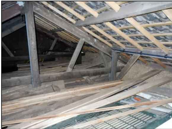
Figuur 8. Zolder van open kapschuur. Op de vloering en de balken zijn geen sporen van gebruik door uilen aangetroffen.
