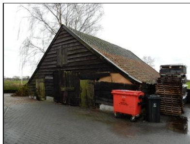
Figuur 3. Houten opslagschuur (te slopen)
