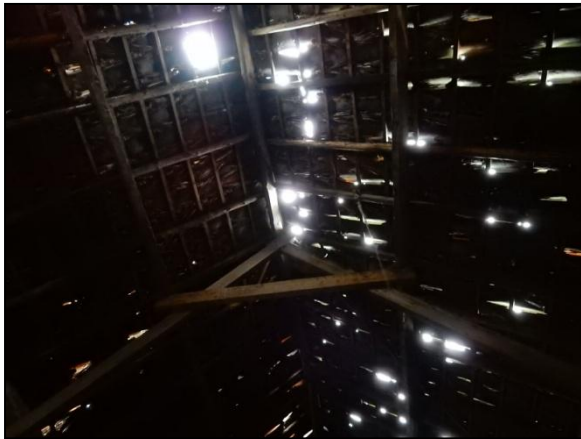
Figuur 10. Openheid van het dak van de schuur is ongunstig voor microklimaat voor vleermuizen.
