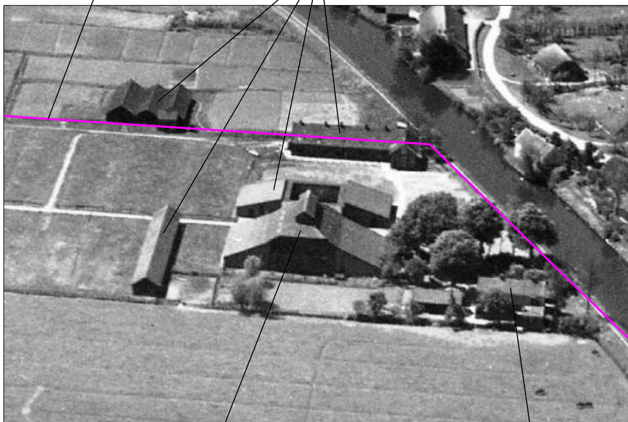
Luchtfoto 1936 (richting westen)
