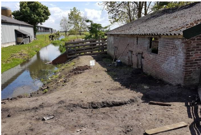
Foto 3: oostelijk gedeelte locatie (vanaf noordzijde)
