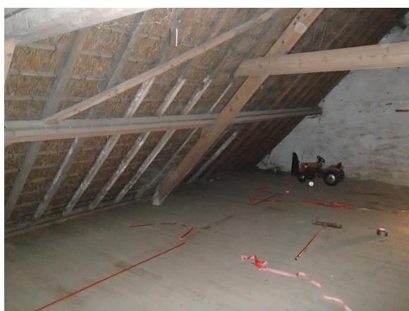
foto 5: zolder geen asbestverdacht materiaal
