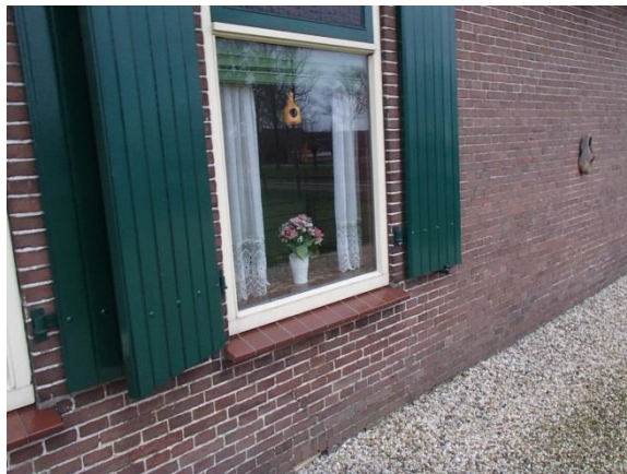
foto 10: buitenzijde woning geen asbestverdacht materiaal
