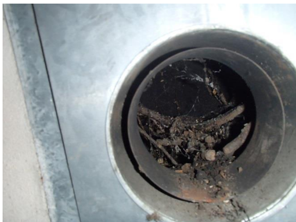
foto 7: schoorsteenkanaal geen asbestverdacht materiaal
