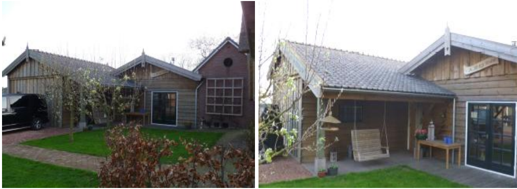
Foto's bestaande situatie
