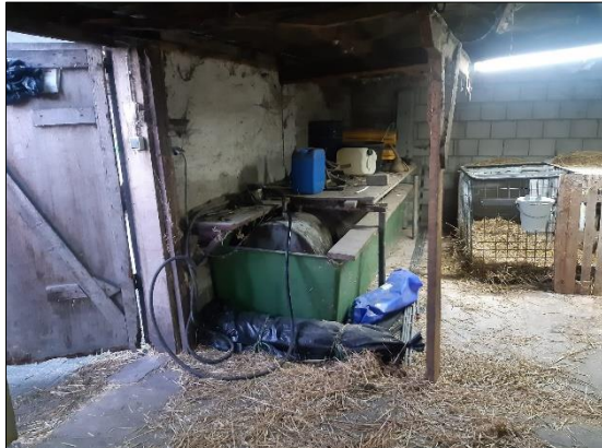
Foto 5: Dieseltank. (d.d. 21 januari 2021)
