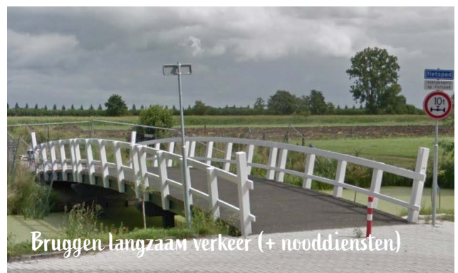
Brug toegangsweg (bestaande brug)
