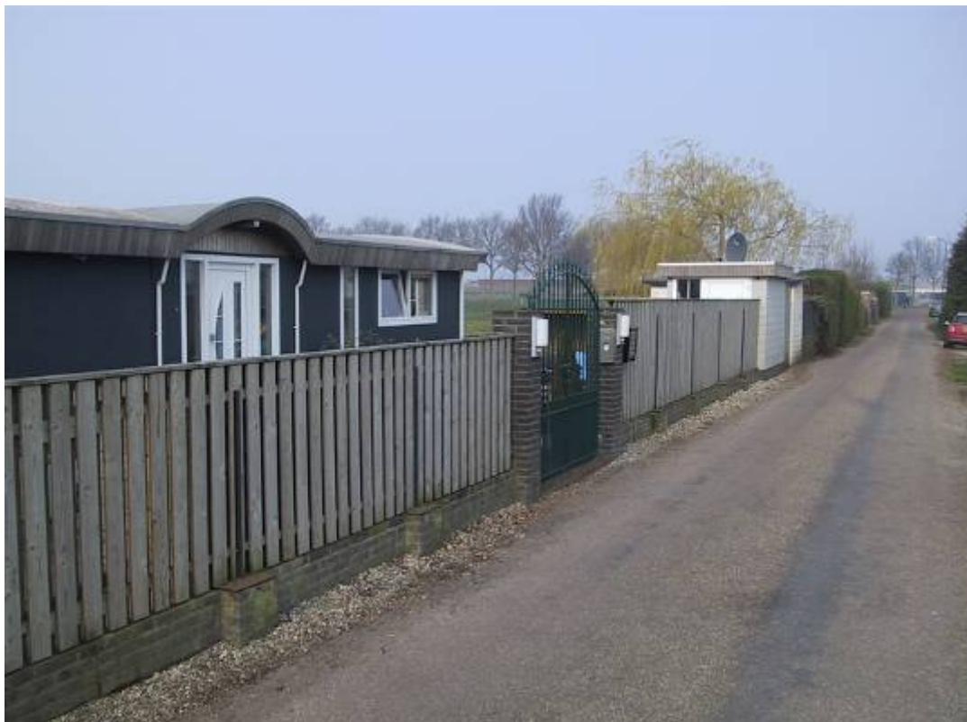
Wederom schutting ter hoogte van nummer 47.
