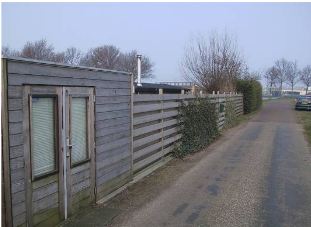
Schutting ter hoogte van nummer 51.
