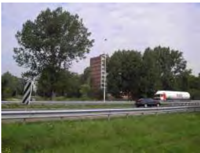
A28 en flatbebouwing Amersfoort
