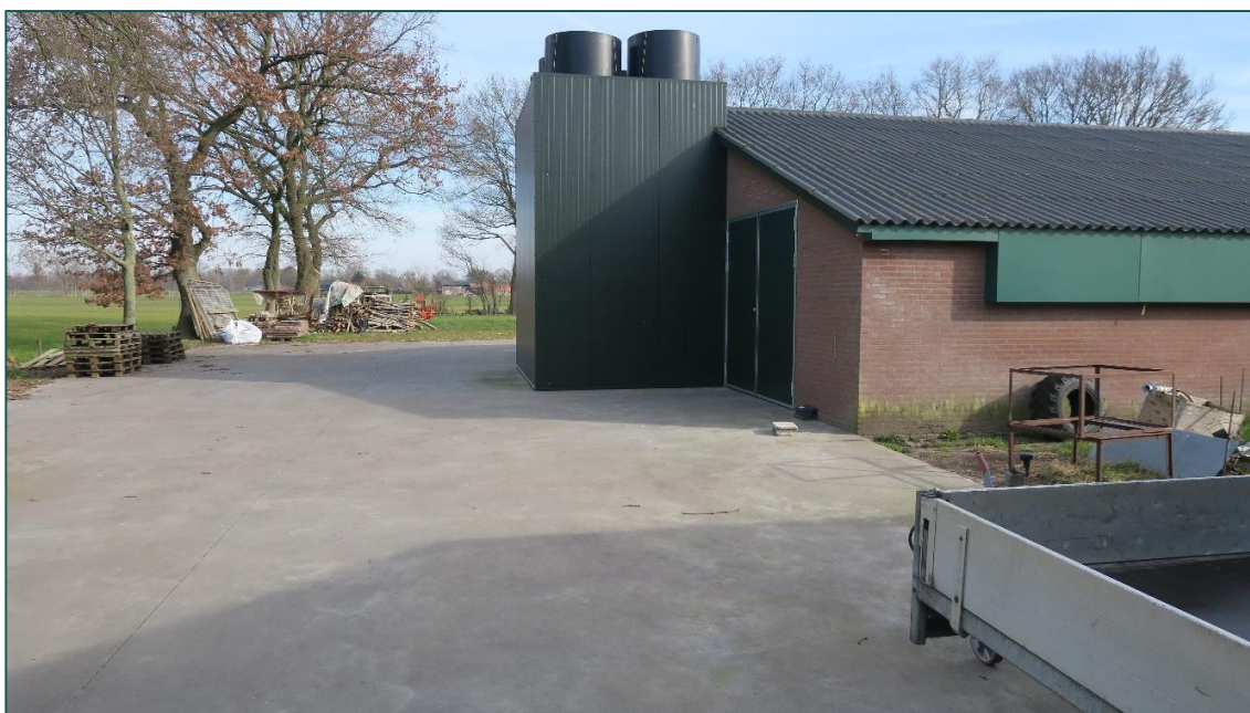
Figuur 2 Bij de kopgevels van de stallen is veel verharding aanwezig.
