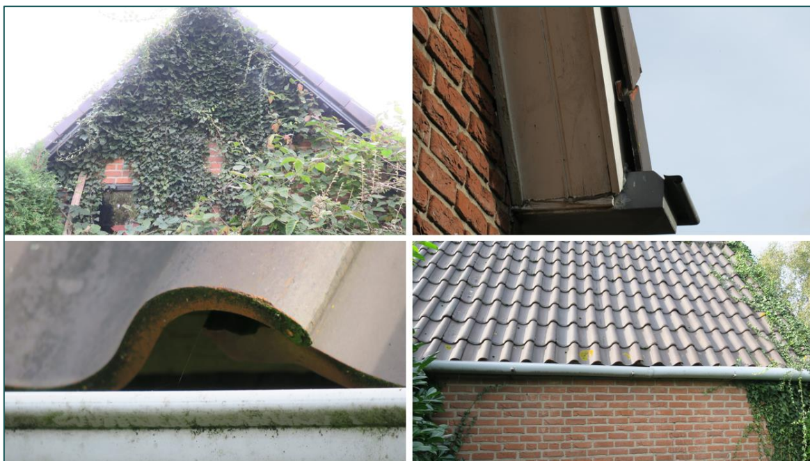
Figuur 3.2 In de woning en garage zijn meerdere elementen aanwezig die geschikt kunnen zijn voor huisvesting en leefgebied van de huismus.
