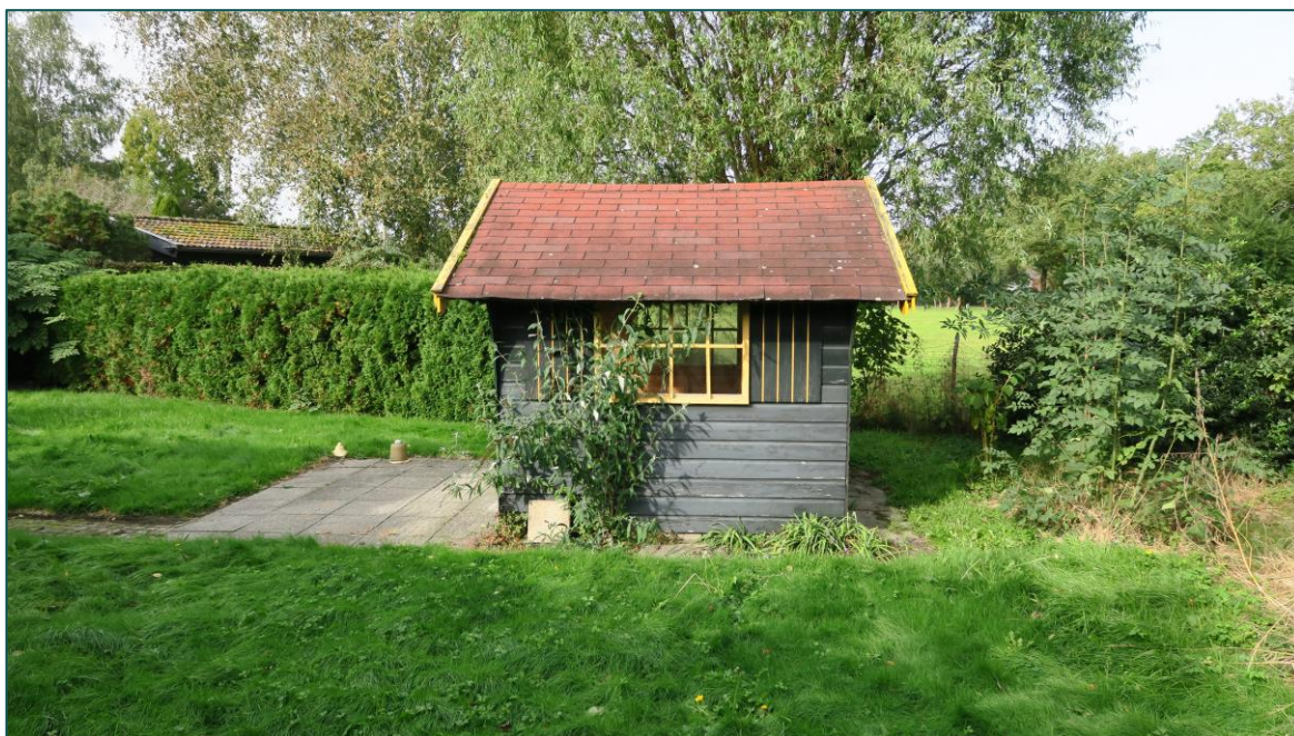
Figuur 3 De tuinschuur is opgebouwd uit houten rabatdelen met een bitumen dakbedekking.
