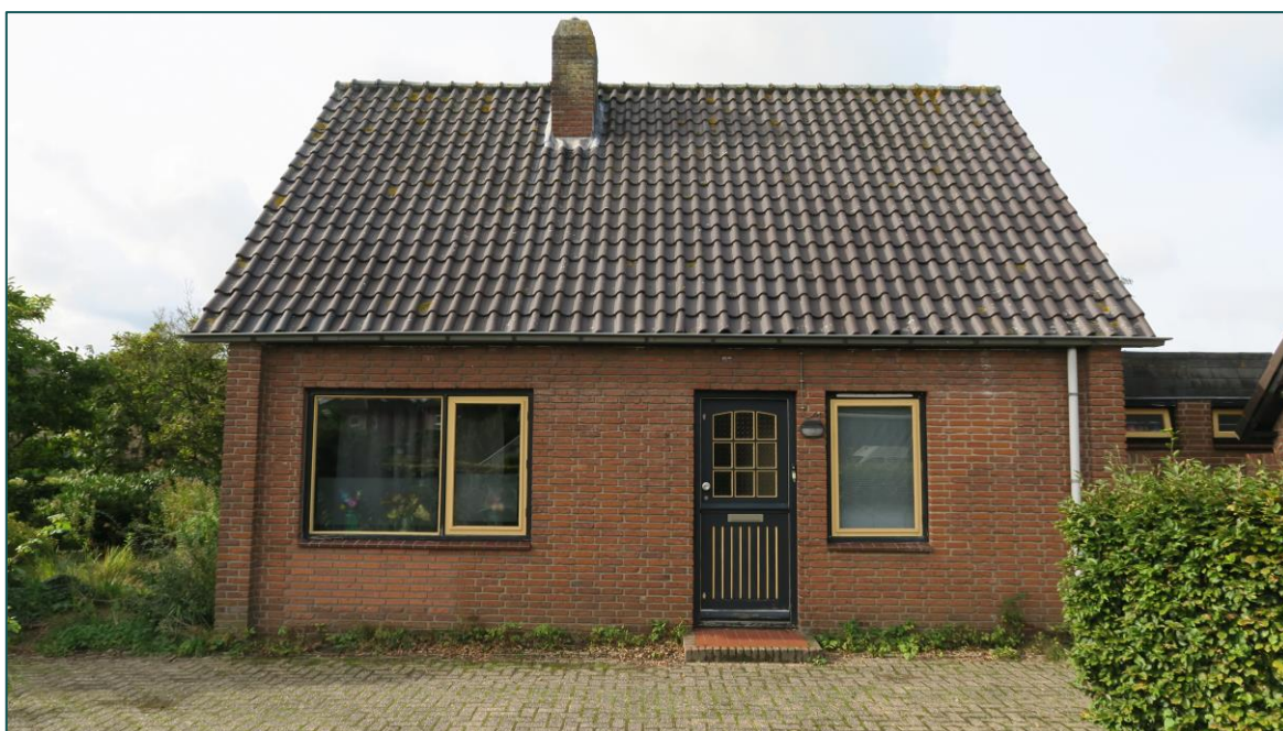
Figuur 2 De woning bestaat uit een woning bevat een spouw en een pannendak met dakbeschot.
