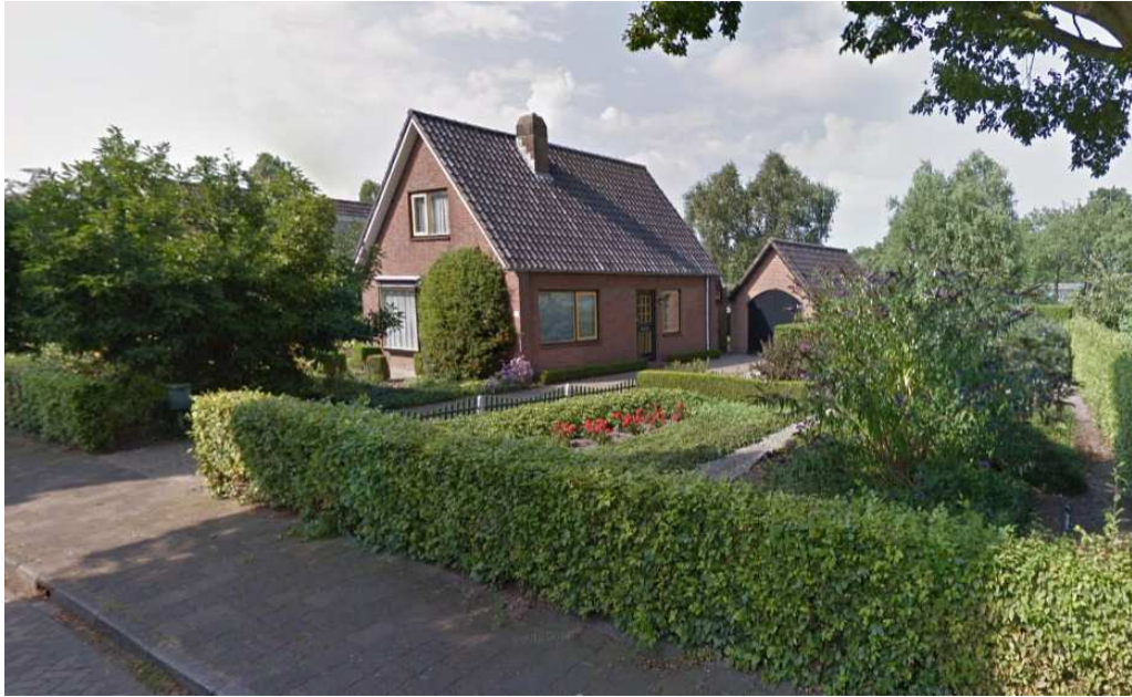
Afbeelding: Bestaande woning Verjaagde Ruiteweg 51 (bron Google Street View)
