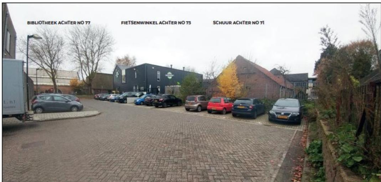
Aanzicht plangebied vanaf winkelcentrum Hamershof (bron: Arcom BV)
