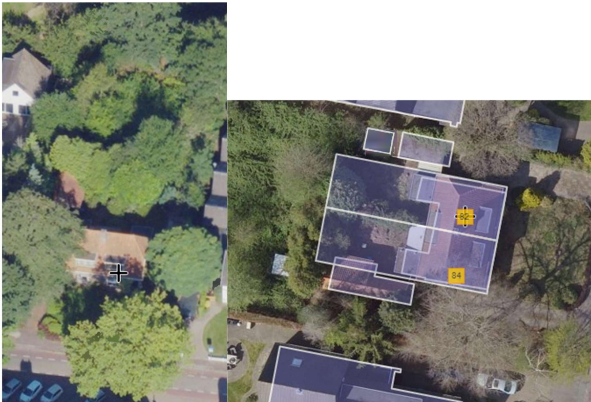
Afbeelding, bouwlocatie Hamersveldseweg 82-84 (Bron: Street Smart) ([22 juni 2022])
