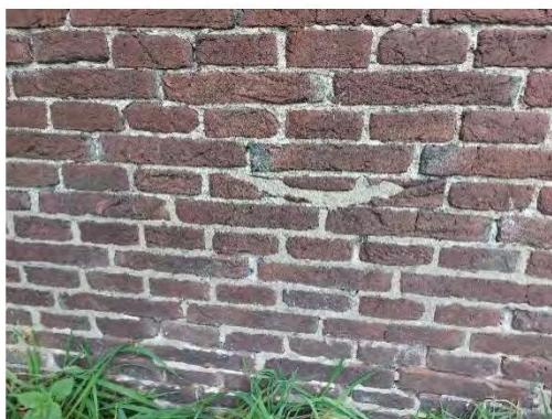
9 Detail opname metselwerk
