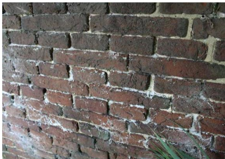
7 Links aanheling t.b.v. kleiner mestluik? 8 Zoutuitbloei aanwezig en cementmortelherstelling
