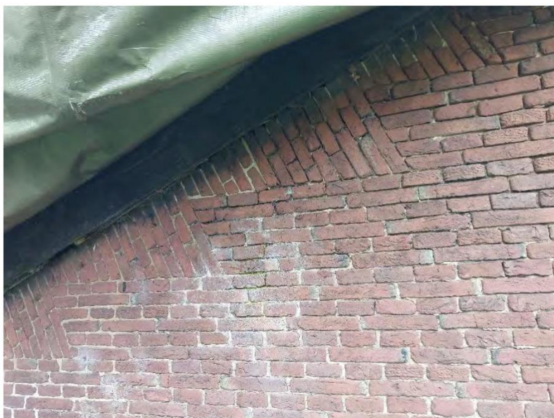
6 Mooi detail - vlechtwerk noord- en zuidgevel dakaansluiting
