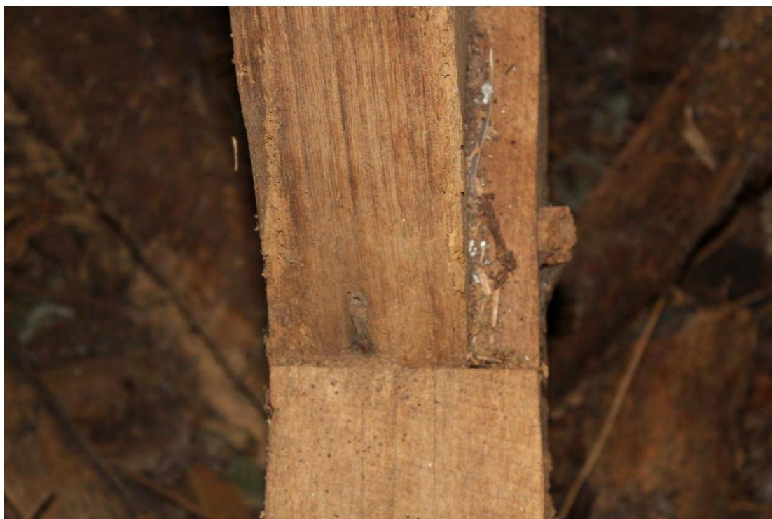
19 Detailopname sporen houtaantasters
