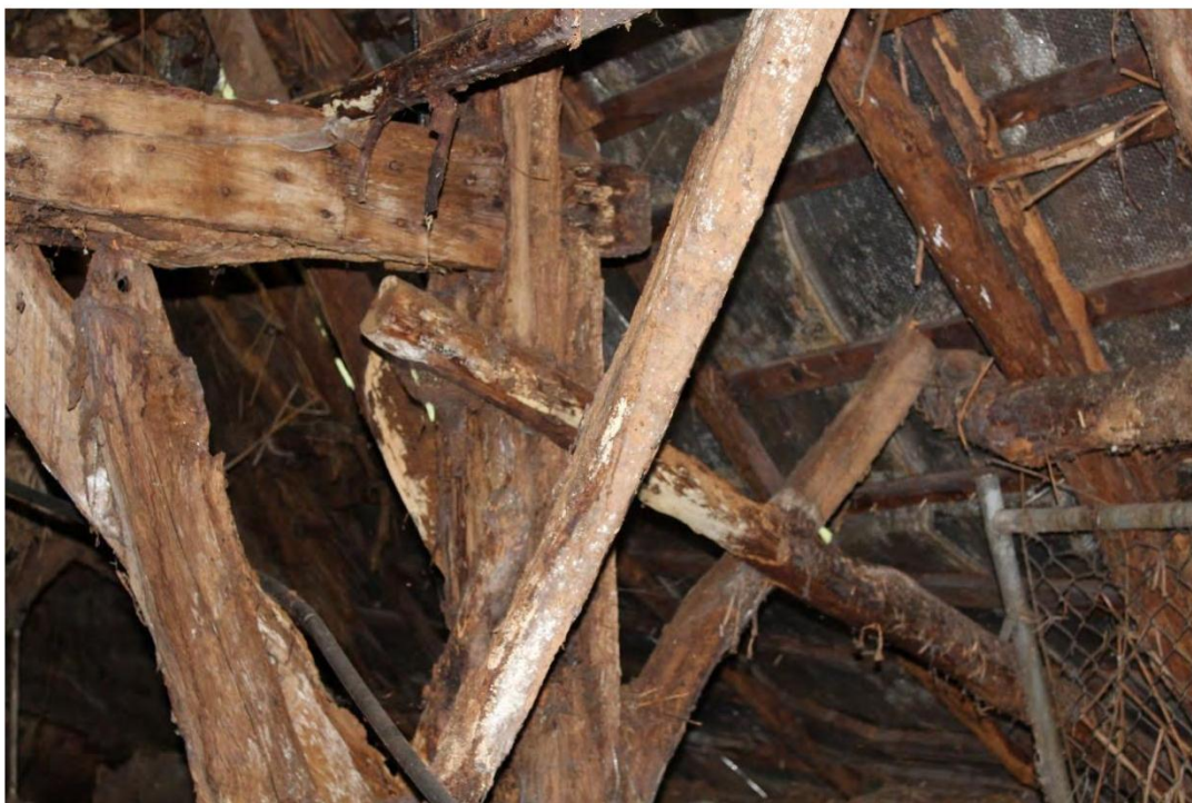
16 Zwaar aangetaste constructie
