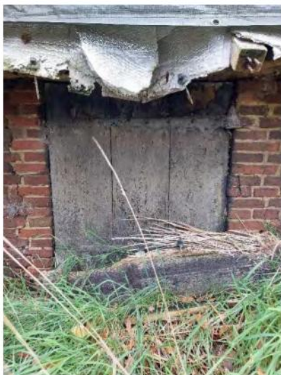
7 Links aanheling t.b.v. kleiner mestluik? 8 Zoutuitbloei aanwezig en cementmortelherstelling
