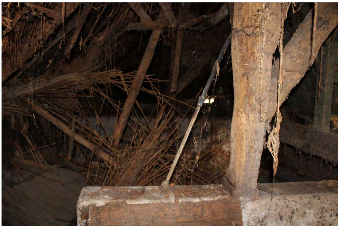
22 Ingekorte staander op later toegevoegde tussenmuur
