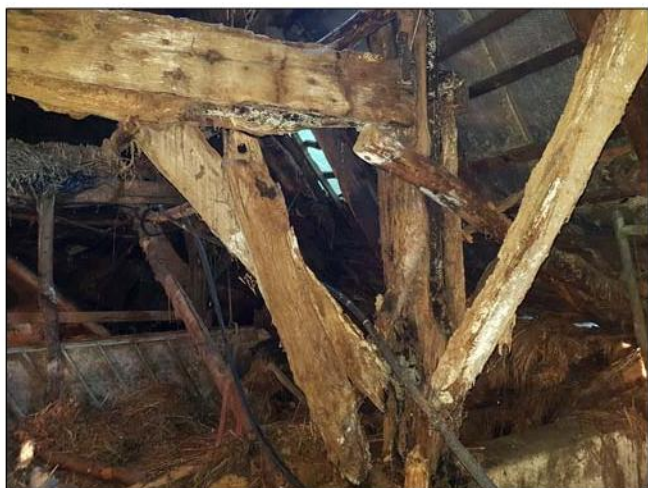
Middelste ankerbalkgebint oostzijde
