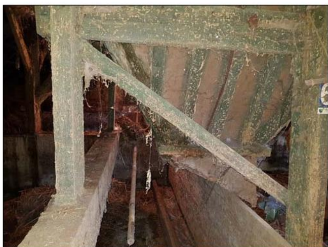
Voersilo sterk aangetast
