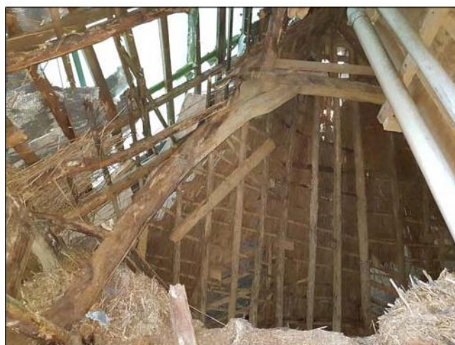
Meest zuidelijke spantconstructie
