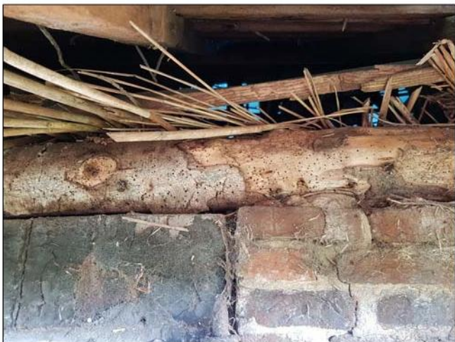
Deel van muurplaat westgevel
