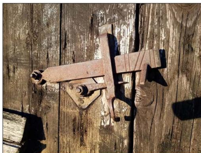
Sluitwerk opgeklampte deur zuidgevel
