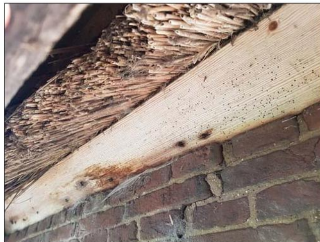
Deel knellat westgevel
