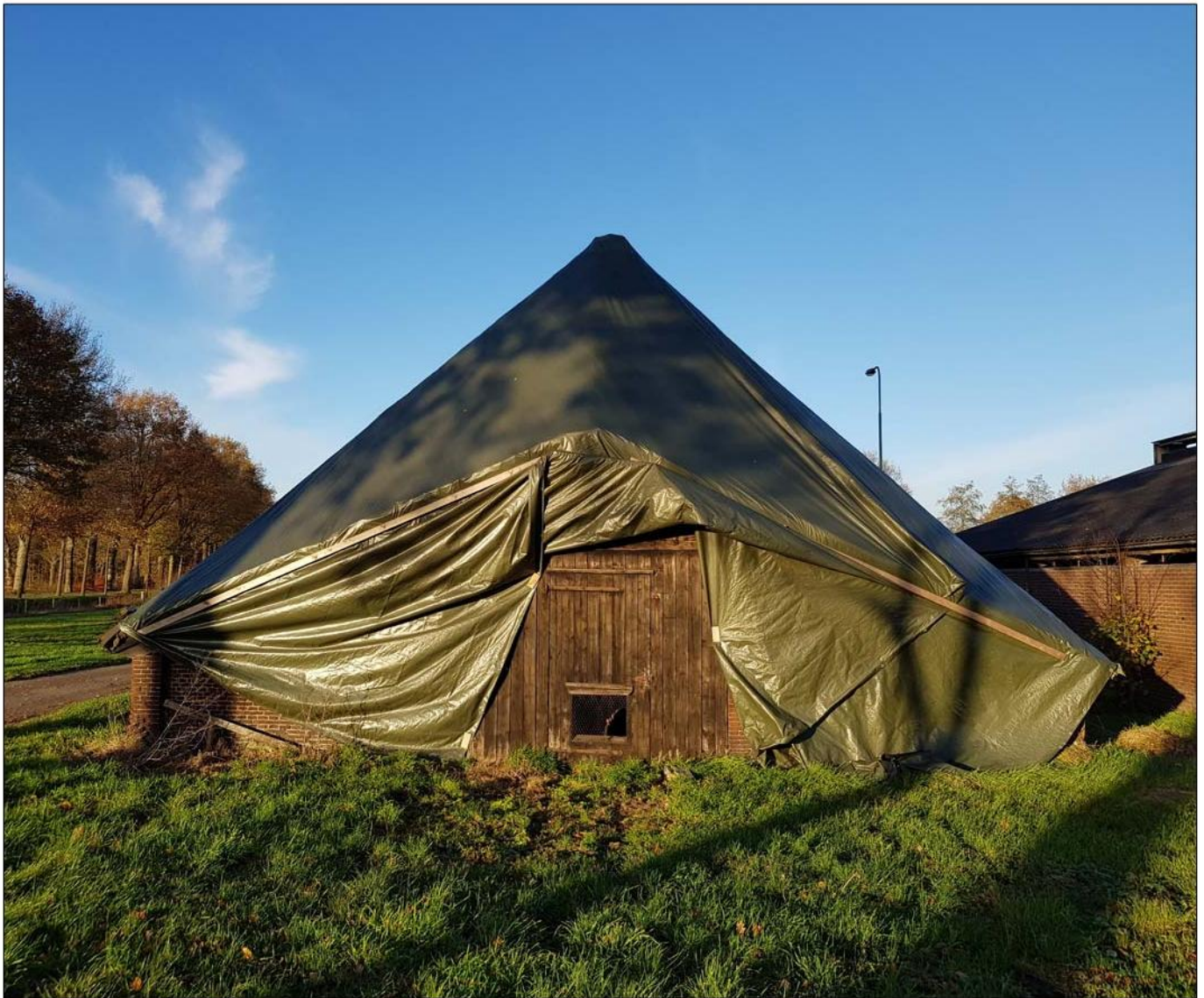
Zuidgevel met opgeklampte deur en verticale houten delen , de gehele schaapskooi is afgezeild.
