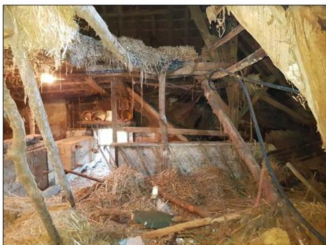
Inrichting, zicht richting noordzijde
