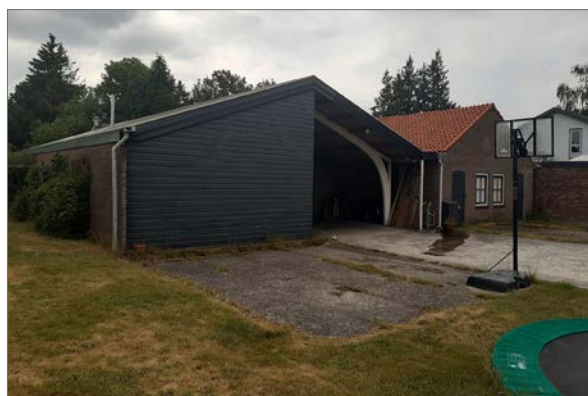
afbeelding | Bestaande bedrijfsgebouwen
