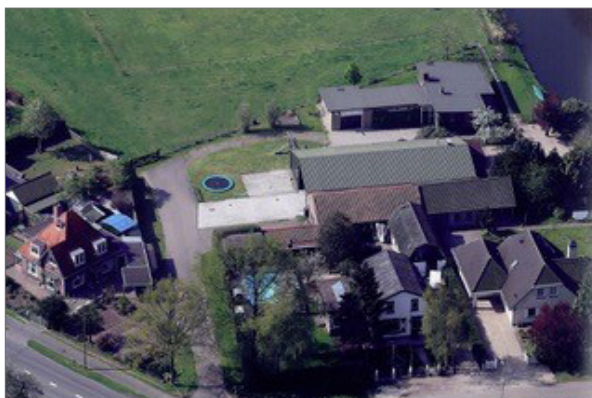
afbeelding | Luchtfoto van het totale terrein.
