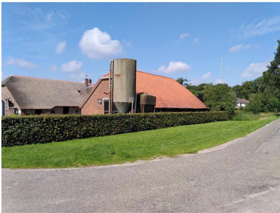
Foto veeschuur in de huidige situatie met beukenhaag
