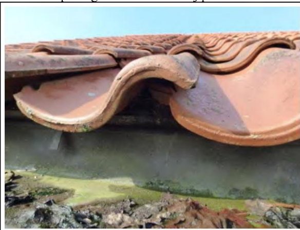
Foto 10 opening onder onderste rij pannen
