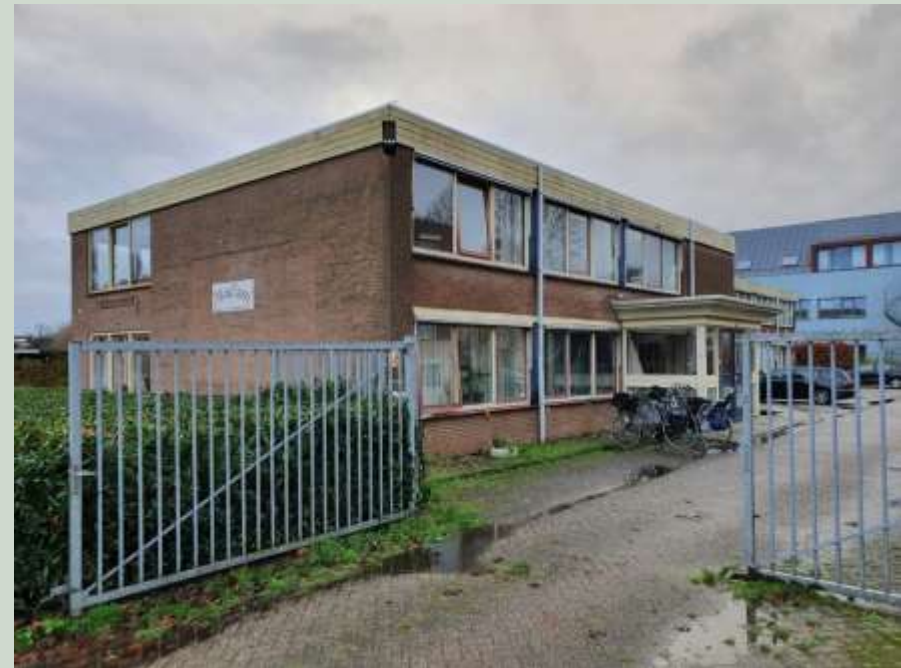
Te slopen opstal
