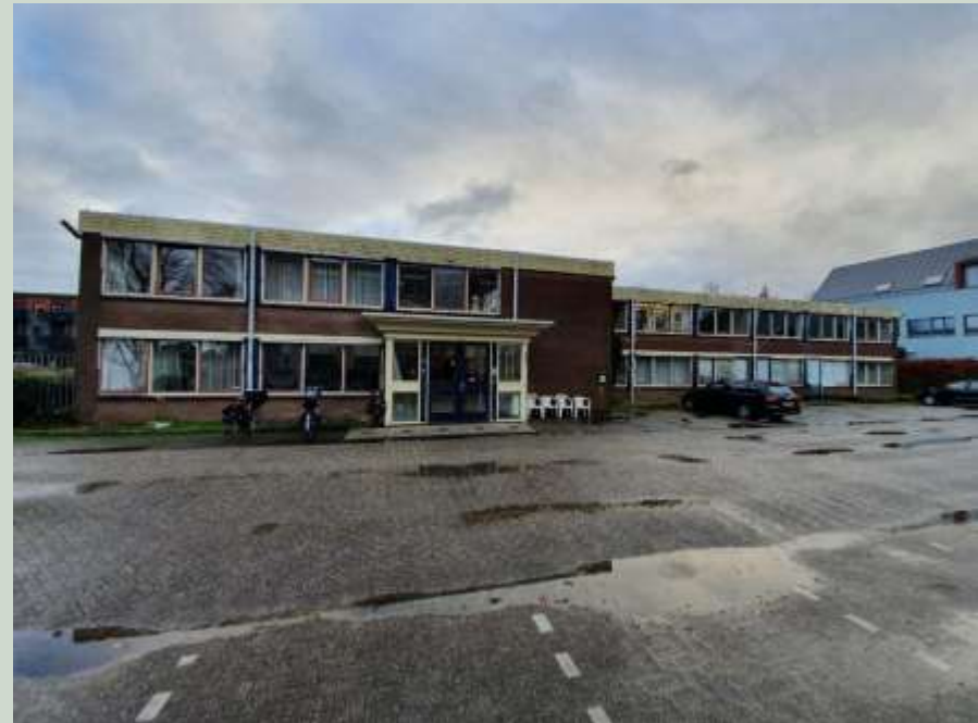
Te slopen bebouwing
