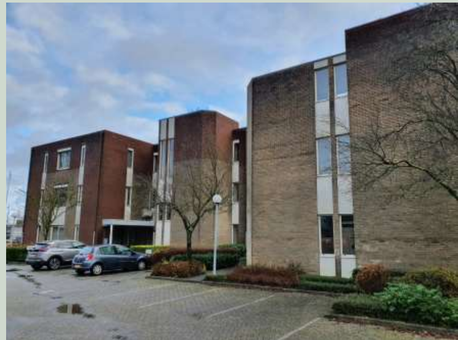
Te slopen bebouwing
