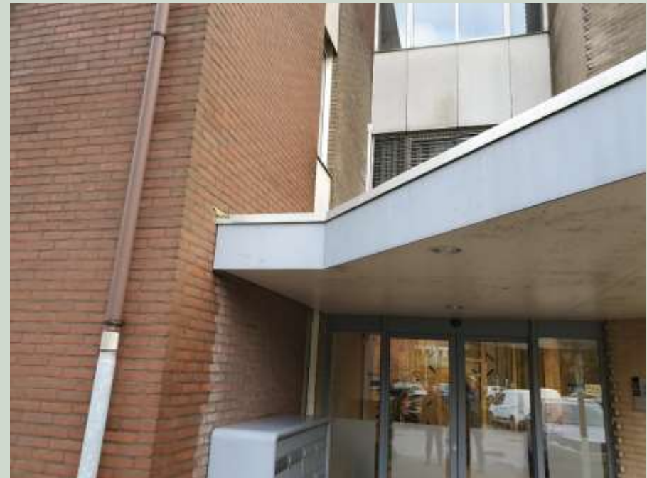
Te slopen opstal / ramen met trespa
