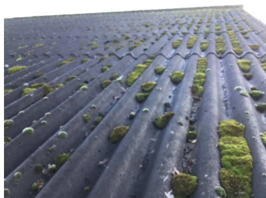
AC golfplaat (dak)
