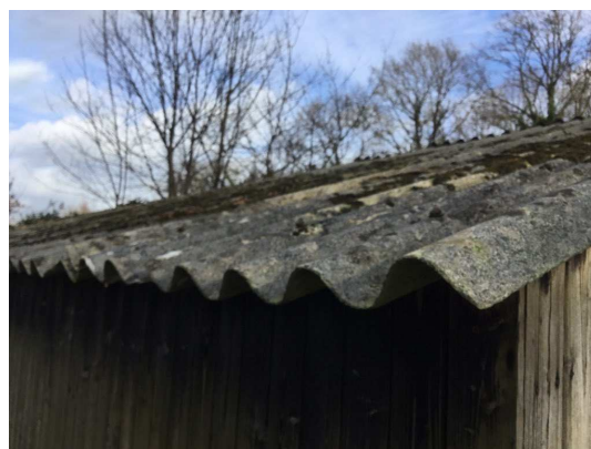
AC Golfplaat (dak)
