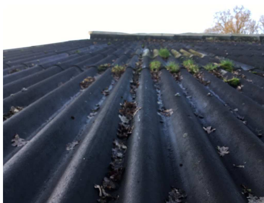
AC golfplaat (dak)
