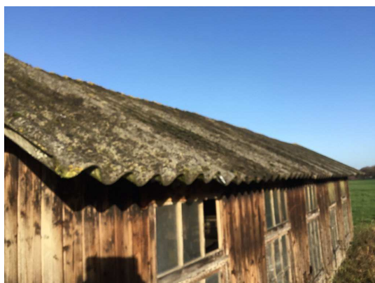
AC golfplaat (dak)
