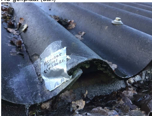
AC golfplaat (dak)
