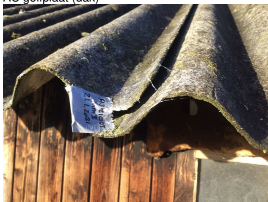
AC golfplaat (dak)
