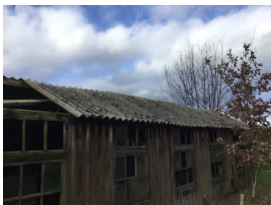
AC golfplaat (dak)
