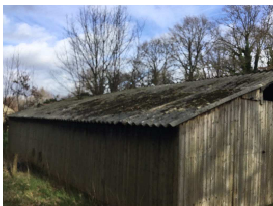
AC Golfplaat (dak)
