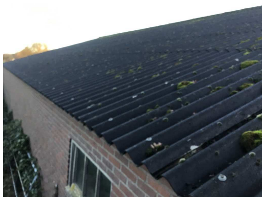
AC golfplaat (dak)
