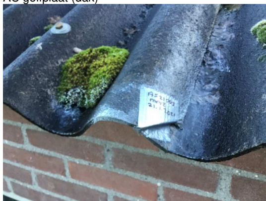
AC golfplaat (dak)
