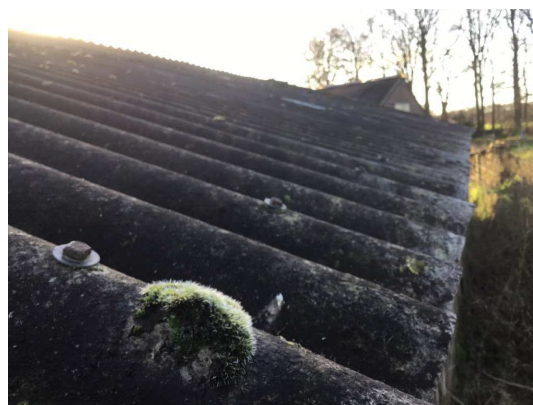
AC golfplaat (dak)
