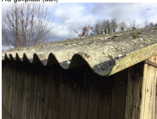
AC golfplaat (dak)
