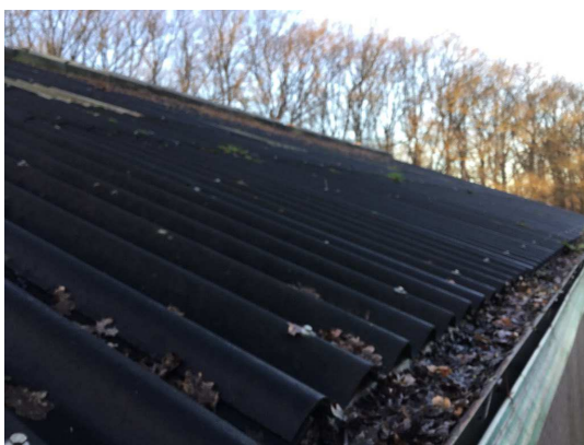
AC golfplaat (dak)
