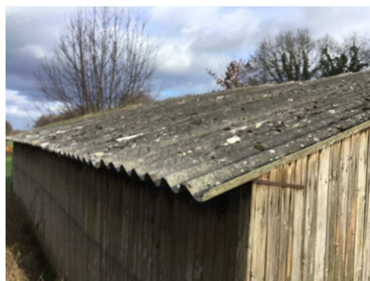
AC golfplaat (dak)
