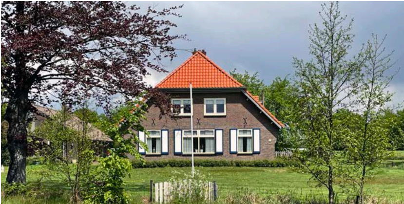
Afb.: Kopgevel; open gevelindeling met grote(re) raampartijen.
