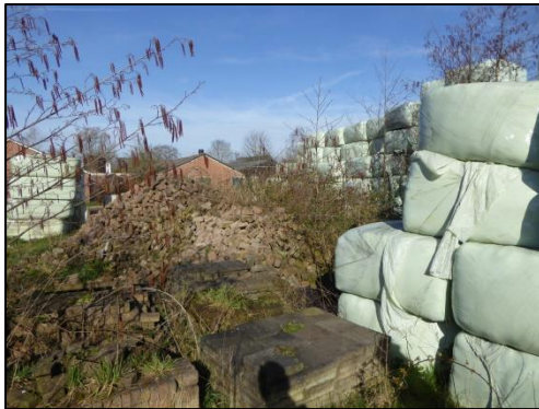
Veel losliggende stenen en andere puin.
