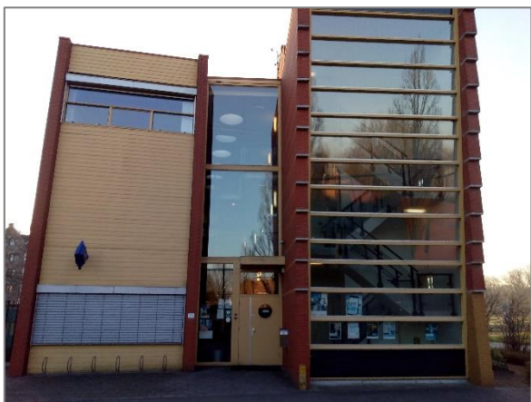
Afbeelding 1.1 | Voorzijde van het gebouw.
