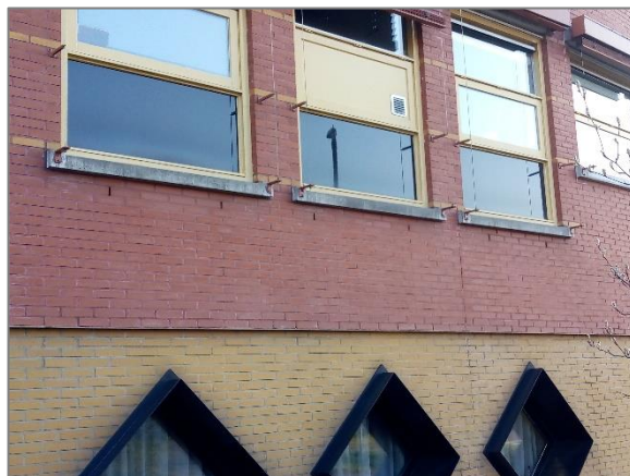
Afbeelding 3.1 | Meerdere stootvoegen zijn in het gebouw aanwezig.
