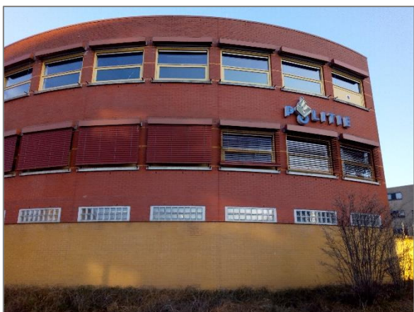
Afbeelding 1.3 | Oostzijde van het gebouw.
