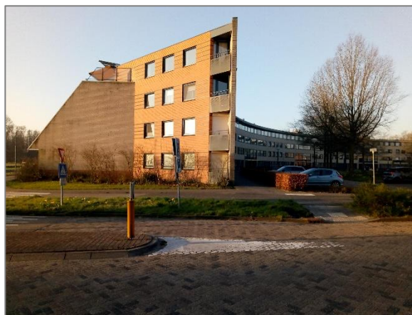
Afbeelding 1.8 | Gebouw ten zuiden van het plangebied.
