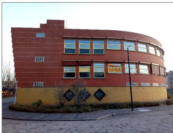
Afbeelding 1.2 | Zuidzijde van het gebouw.
