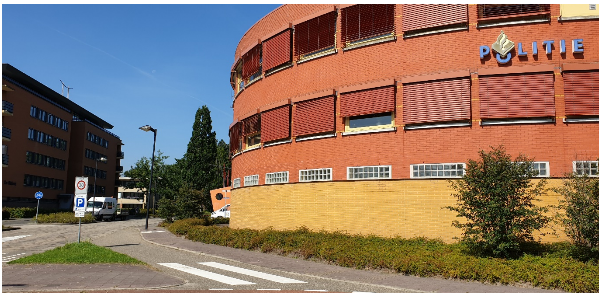
Foto 1: Zicht vanuit de zuidoostzijde op de onderzoekslocatie.
