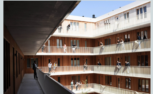
Afwijkend materiaalgebruik binnenplaats mogelijk Bartok, Arnhem (Barcode Architects)
