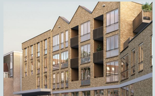
Buitenruimtes binnen de bouwmassa Huis van Leusden (DP6)
