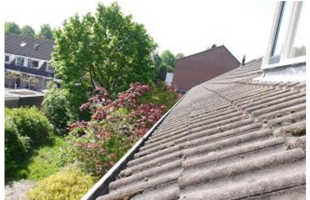
Foto 10: pannendak z.o-zijde gezien vanuit dakkapel. (foto Botani-Specialist)
