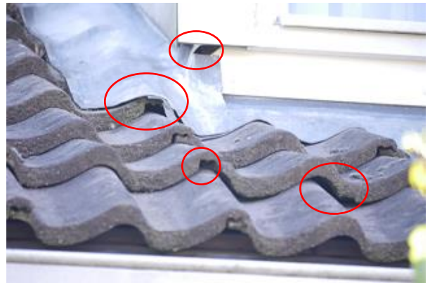
Foto 18 en 19: Aansluiting dakkapellen en vorsten met pannendak met mogelijk invliegopeningen; echter geen verblijfplaatsen aangetroffen. (foto Botani-Specialist)
