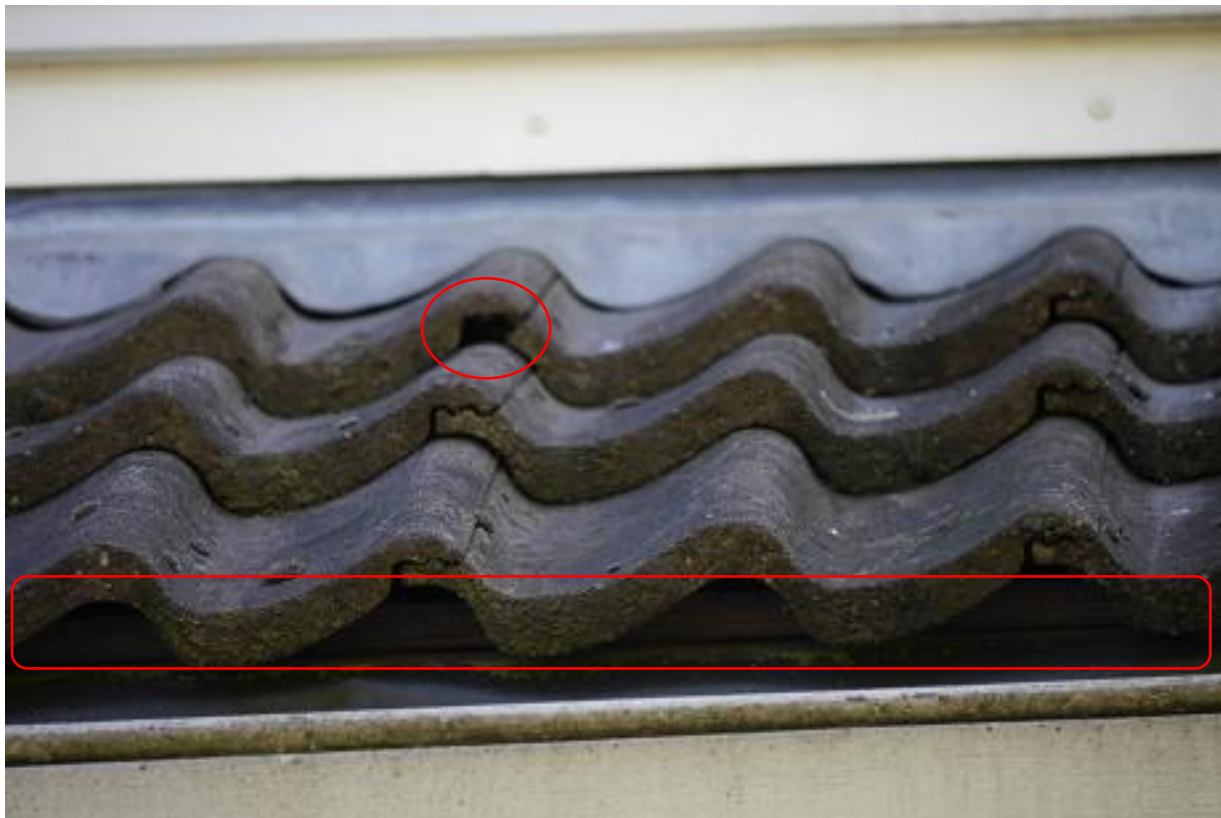
Foto 16: Aansluiting dakgoot en onderste rij dakpannen met mogelijk invliegopeningen / nestlocatie voor huismussen of vleermuizen; echter geen verblijfplaatsen aangetroffen. (foto Botani-Specialist)
