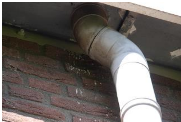
Foto 17 en 18: Aansluiting aansluitingen goot met gevel of regenpijp met mogelijk invliegopeningen. (foto Botani-Specialist)
