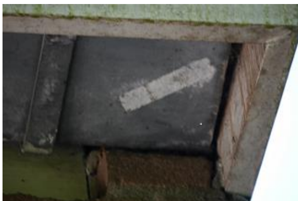
Foto 17 en 18: Aansluiting aansluitingen goot met gevel of regenpijp met mogelijk invliegopeningen. (foto Botani-Specialist)
