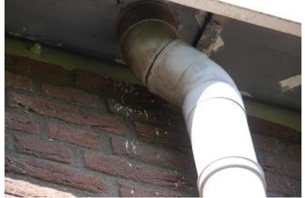
Foto 17 en 18: Aansluiting aansluitingen goot met gevel of regenpijp met mogelijk invliegopeningen. (foto Botani-Specialist)
