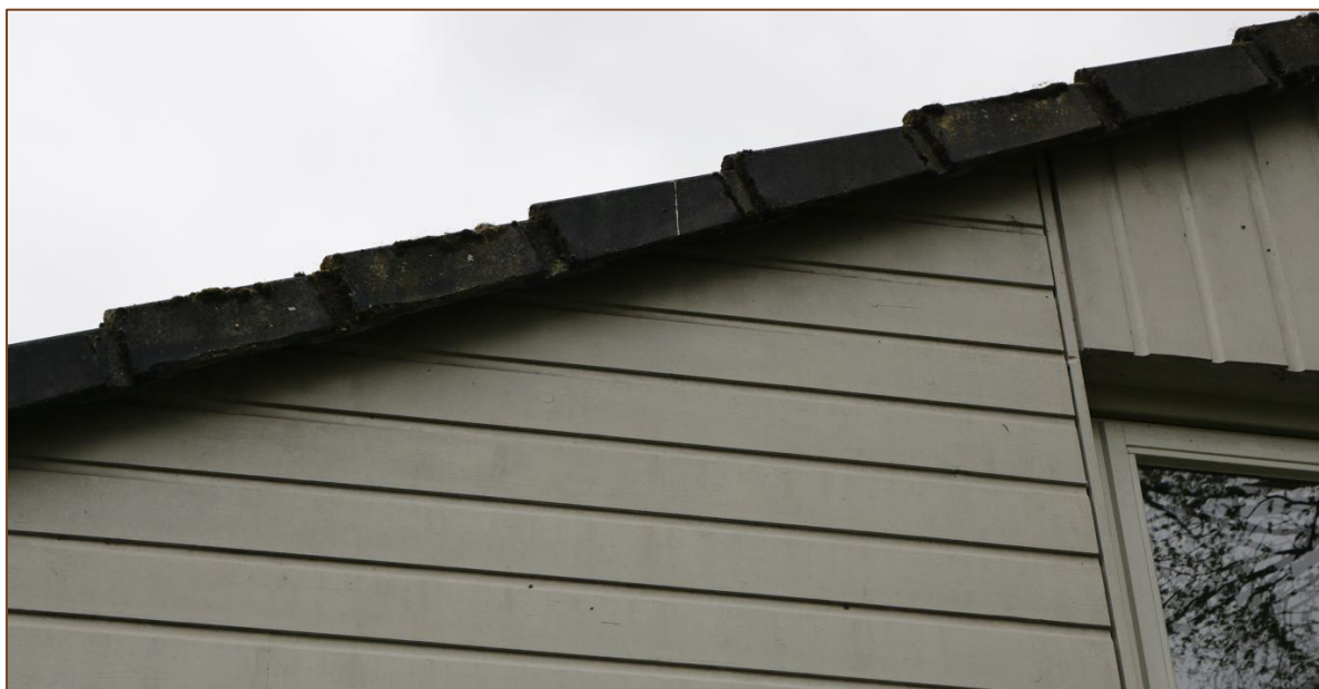
Figuur 6. De 'Villa Buitenhof' in het plangebied is door de aanwezige hoekpannen potentieel geschikt als verblijfplaats voor gebouwbewonende vleermuizen (foto R. Boerboom).
