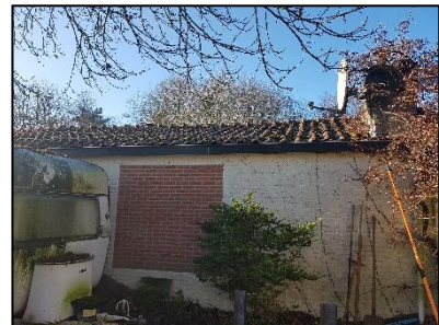
Figuur 5. Oostzijde van de bebouwing.
