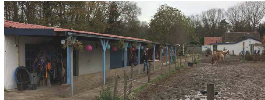
6. idem, vrij zicht tussen stenen gebouw en bedrijfsgebouw met stallen.
