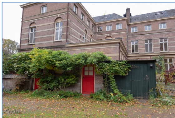
Zijaanzicht aanbouw zuidzijde
