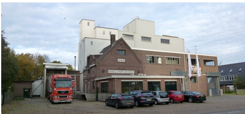
Vooraanzicht van het hoofdgebouw, bestaande uit het kantoor en de fabriek. Het plangebied bevindt zich aan de rechterkant (de noordzijde) van het gebouw.
