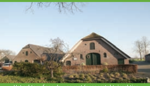
Het achtererf aan de weg met (ongepaste) tuinachtige inrichting ter plaatse van het gedempte water.
