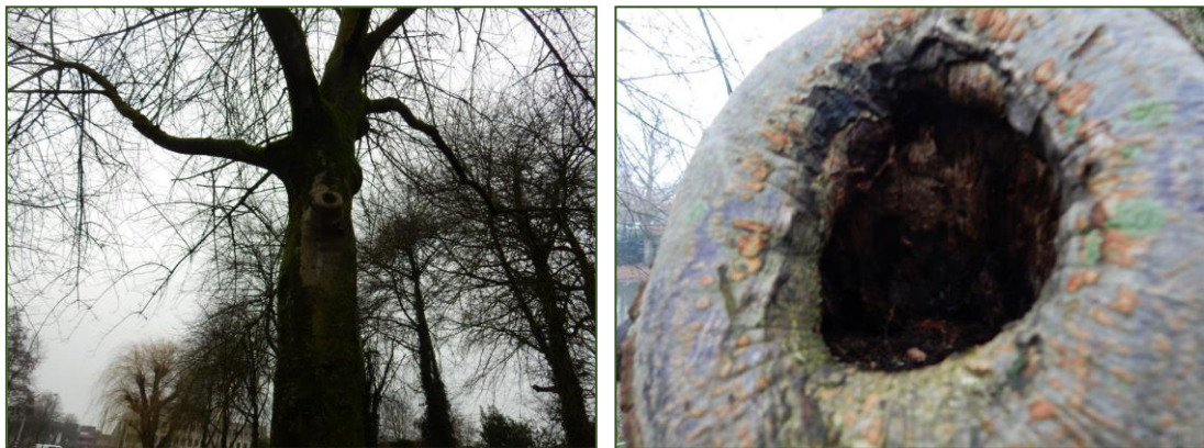
Foto's: Potentiële holte voor vleermuizen blijkt bij nadere inspectie niet geschikt te zijn.
