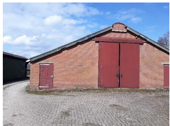
Figuur 2.3: Aanzicht op de noordoostelijke schuur vanuit het zuiden
