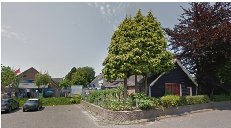
Afbeelding 7: De voormalige stal vanaf het parkeerterrein aan de achterzijde.
