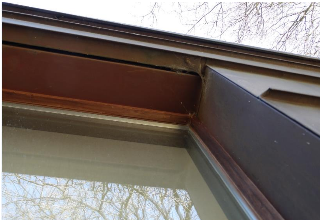
Figuur 5. Geschikte spleten in raamkozijnen van tentoonstelling gebouw voor gewone dwergvleermuis om te gebruiken als verblijfplaats, foto; Leon Burgwal, stagiair RHDHV.
