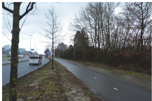
Foto 17. Noordoostrand plangebied langs de Randweg met houtwal en overwoekerde betonnen muur, kijkrichting naar oosten
